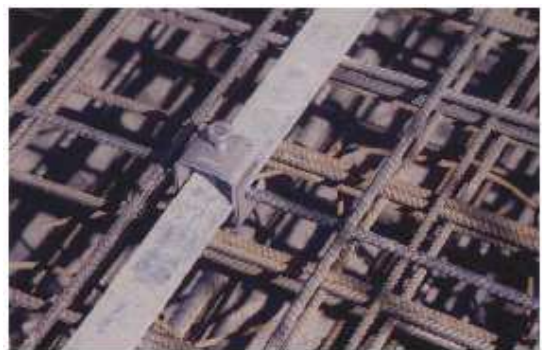
Bild 4: Blitzschutz-Fundamenterder auf Bewehrung
