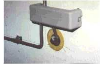
Bild 7: Erdungsfestpunkt für Potentialausgleichschiene
