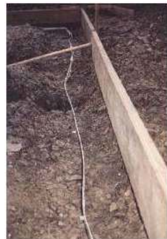
Bild 1: Fundamenterder in unbewehrtem Fundament
